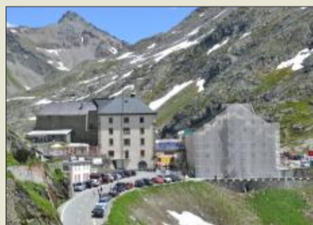
L'Auberge et l'Hospice en cours de rénovation.
